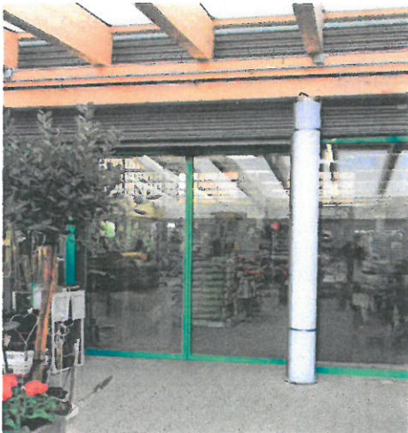
klimatische Trennung von Innen- und Außenbereich im Raiffeisenmarkt Gnarrenburg
